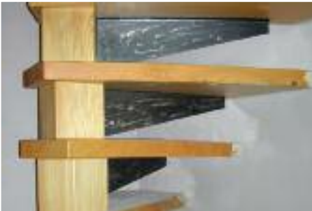
26_Scala struttura portante in ferro gradini in larice
