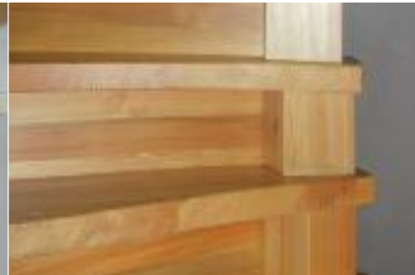
27_Scala struttura portante in ferro gradini e alzate in larice
