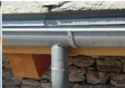
12_Gronda in "Rheinzink" e attacco gronda pluviale
