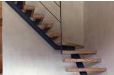
25_Scala struttura portante in ferro gradini in larice
