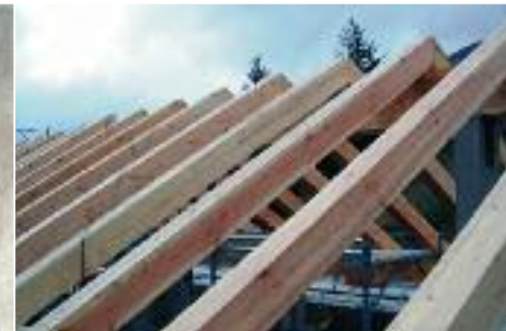
10_ Particolare struttura lignea
