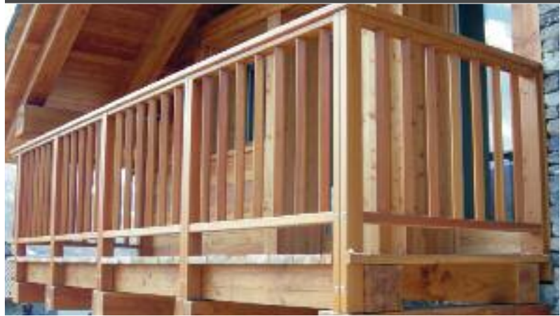
21_Particolare ringhiera balcone
