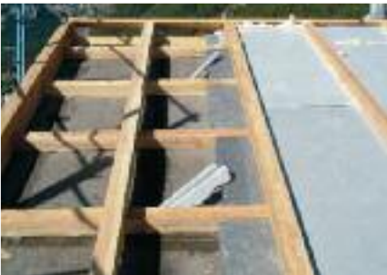
11_Particolare listellatura e isolamento tetto
