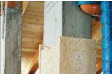
08_ Particolare rivestimento pilastro in "Eraclit"
