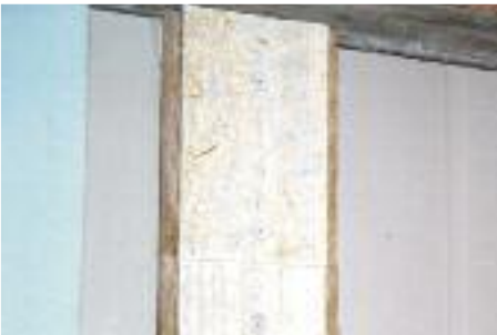
07_Da destra: cartongesso, pilastro rivestito, "Edilfiber"
