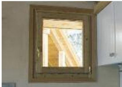
30_Vista interna finestra
