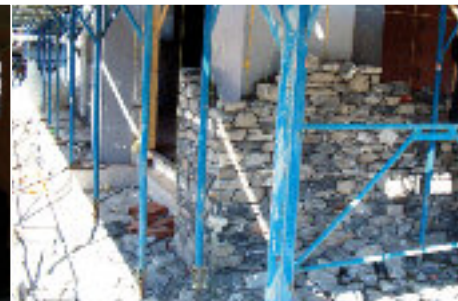
04_Realizzazione muro in pietra locale
