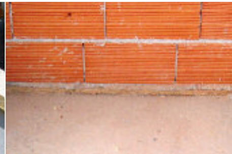
08_Particolare bandella Eraclit sotto muro
