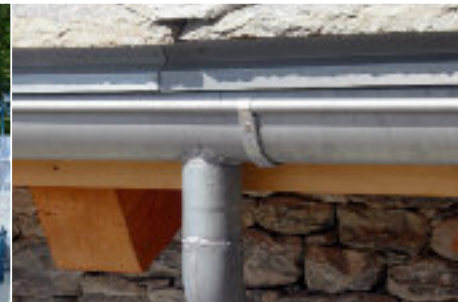
16_Gronda in "Rheinzink"® e attacco gronda pluviale
