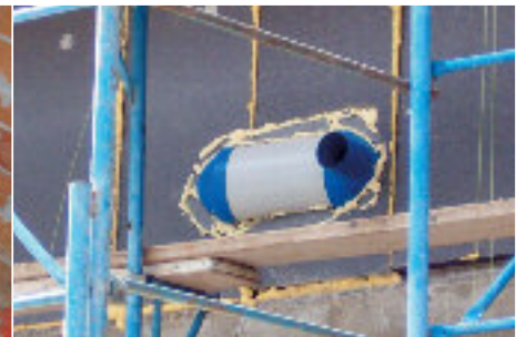
49_Vista esterna "Silentio" durante la posa
