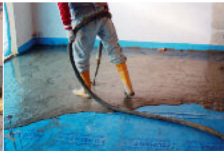
23_Fase del getto massetto autolivellante
