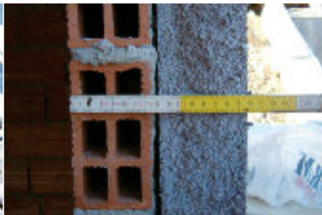
02_Tramezza interna con primo strato isolante
