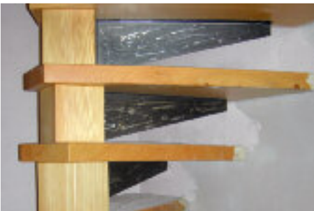
32_Scala struttura portante in ferro gradini in larice
