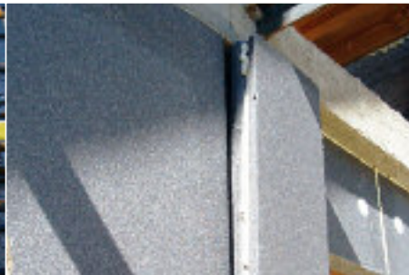
07_Rivestimento pilastro con isolante
