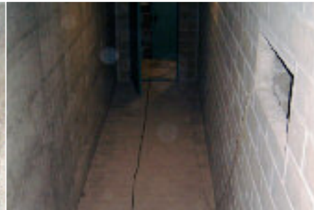
11_Particolare blocchi e c.a. a vista
