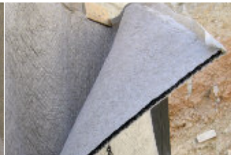
19_Posa geostuoia a protezione
