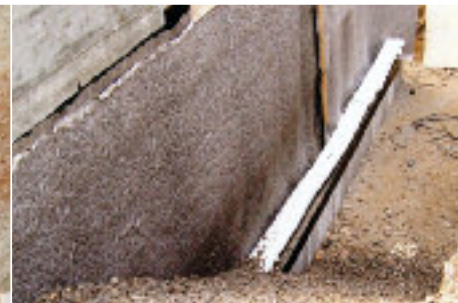
20_Posizionamento doppio tubo drenante
