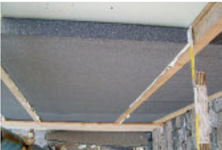
05_Particolare secondo isolamento parete in legno
