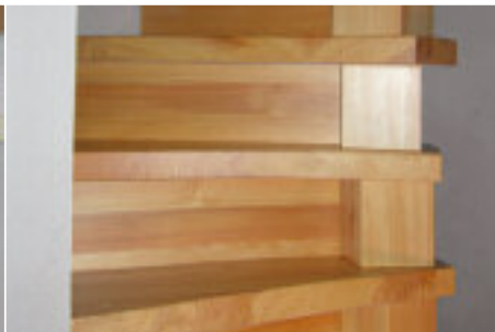
33_Scala struttura portante in ferro gradini in larice
