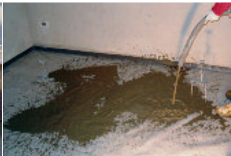
22_Fase del getto cls cellulare
