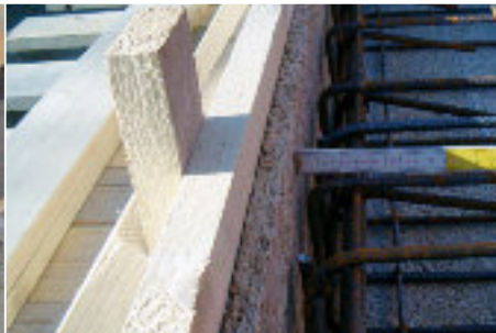
06_Posizionamento Eraclit trave perimetrale
