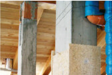
09_ particolare rivestimento pilastro in Eraclit
